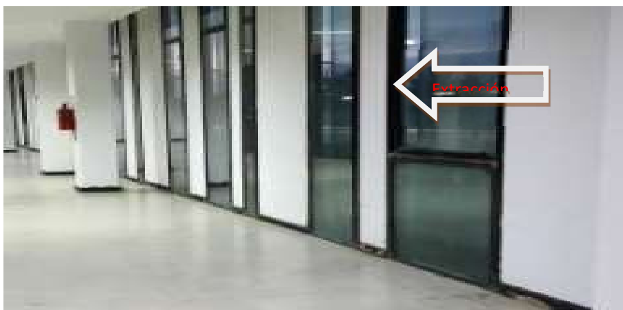
Pasillo interno nivel 1 ala sur
